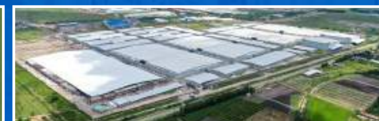
Nhà xưởng Brotex Khu B - Giai đoạn 3
