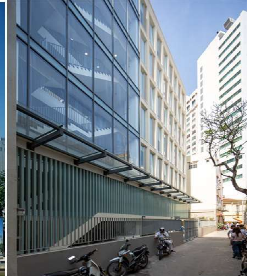
Thi công hoàn thiện
